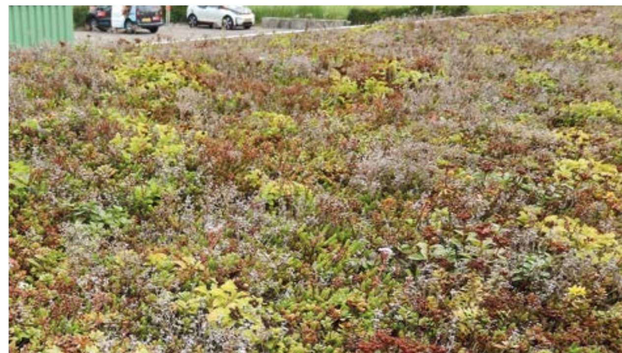
Een groen dak isoleert het gebouw en biedt leefgebied voor insecten en vogels.
